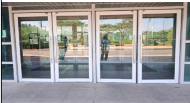
출입문 유효폭 확보 및 점자블럭 설치
