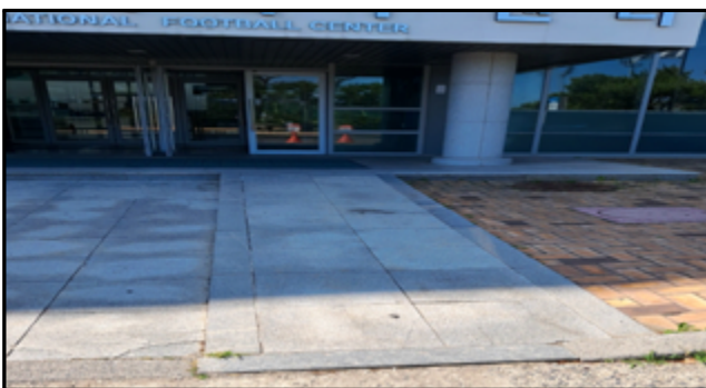
주출입구 경사로 핸드레일 설치
