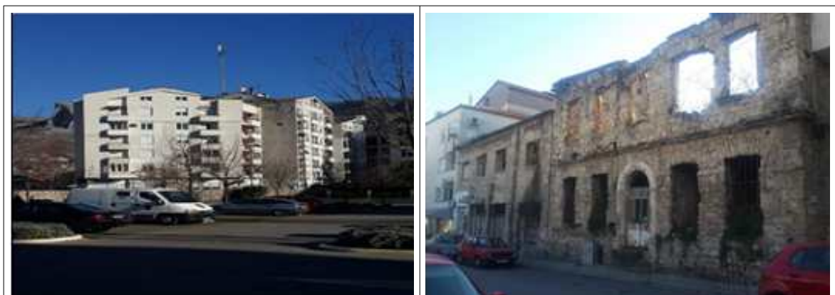
모스타르 내전의 상처 : 좌)아파트 총탄 자국, 우) 파손된 건축물
